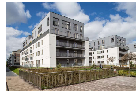
Ostoja-Wilanów (etapa 6.A, edificio C2). Fecha de entrega: Noviembre de 2016. Nº de unidades: 120 viviendas (12,531 m 2 ). Prevendido: 99% (a 30 de septiembre de 2017).
