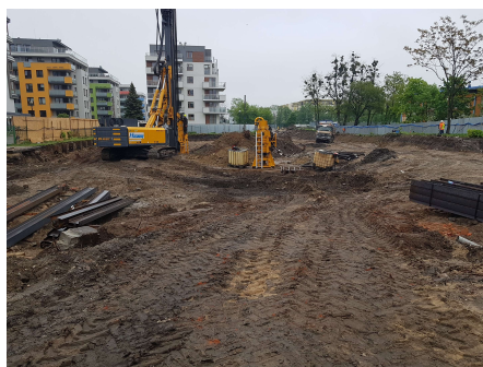
Área de ejecución de obras de Innova Concept, Wrocław
